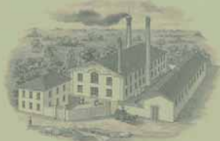
STABILIMENTO in OLAVIGNO
