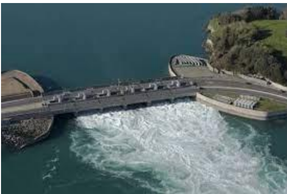
Sbarramento sui fiumi
