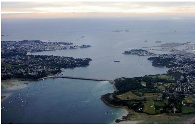
Sbarramento sul canale di collegamento della laguna
