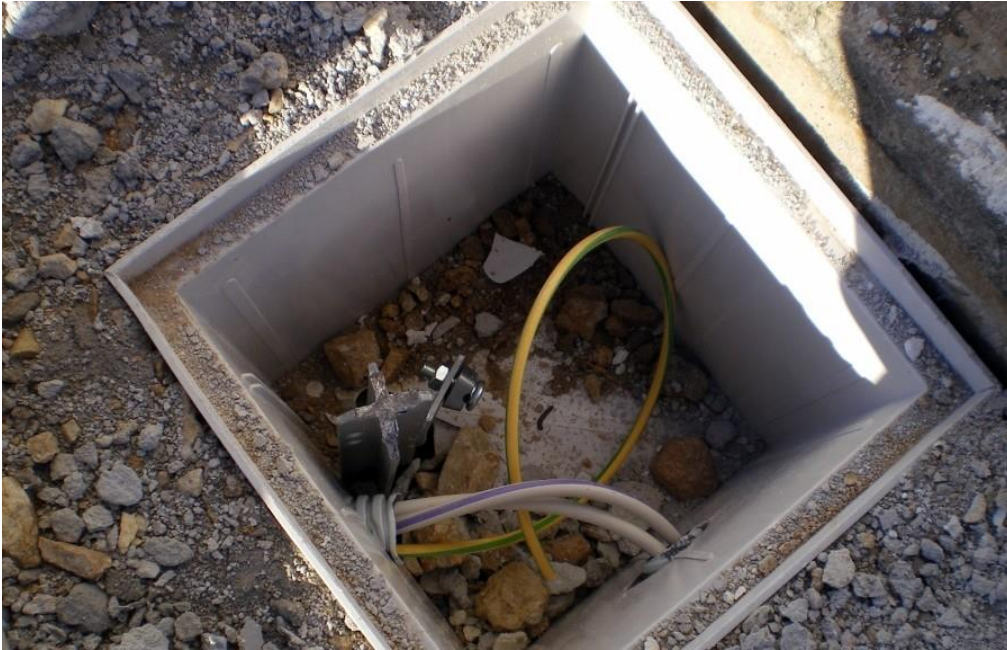
Dispensatore di terra in pozzetto ispezionabile
