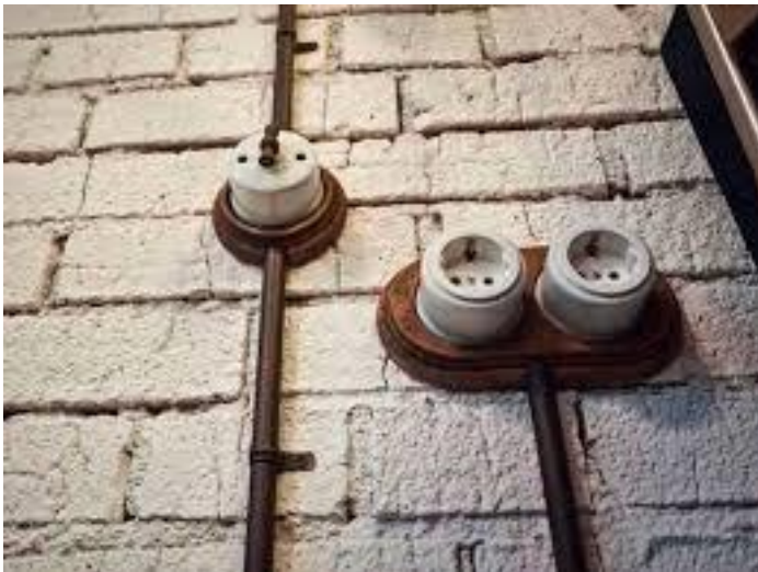
Esempio di esecuzione di vecchio tipo a vista .
