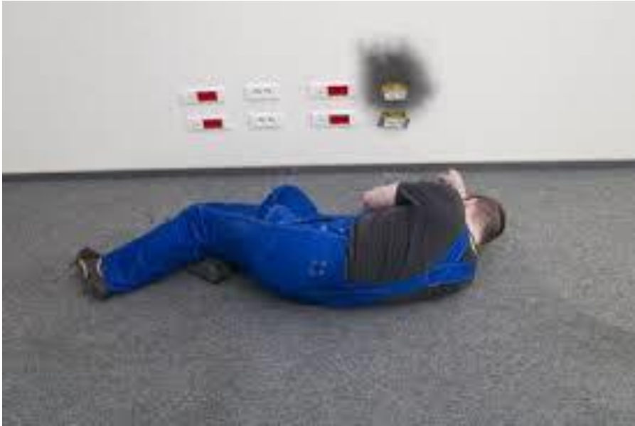
Esempio di incidente da scossa elettrica
